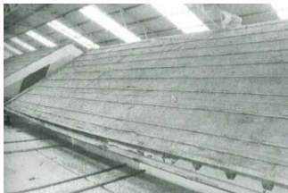
棧瓦解体、野地板を見る
