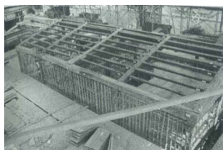
置土と野地板の解体
