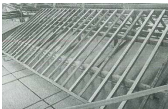
置き屋根用の小屋下地組み
