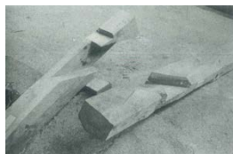
置き屋根登合掌の棟部の継手
