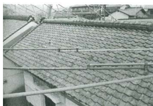
手順 → 棧瓦解体前
