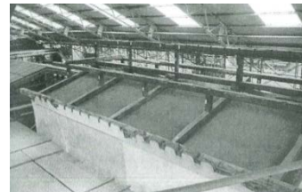
モヤと東の小屋組みの状態
