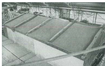
小屋組みを解体
