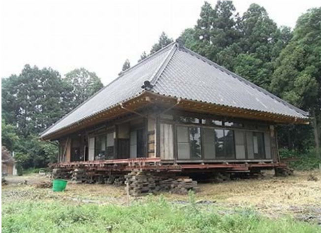
基礎が打てる高さまで家全体をもち上げコンクリート基礎をつくる
