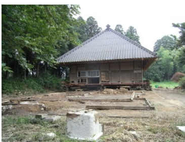
基礎が打てる高さまで家全体をもち上げコンクリート基礎をつくる
