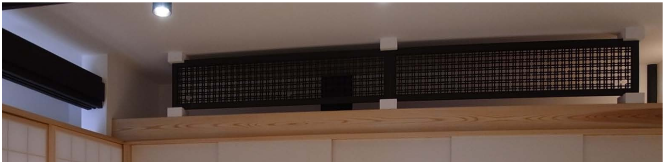
座敷に使われていた吹き寄せ格子の欄間を演出用のスクリーンに転用
