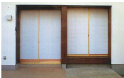
改修後の引込板戸(上)+太鼓障子(下)
