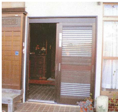
改修前の玄関サッシ
